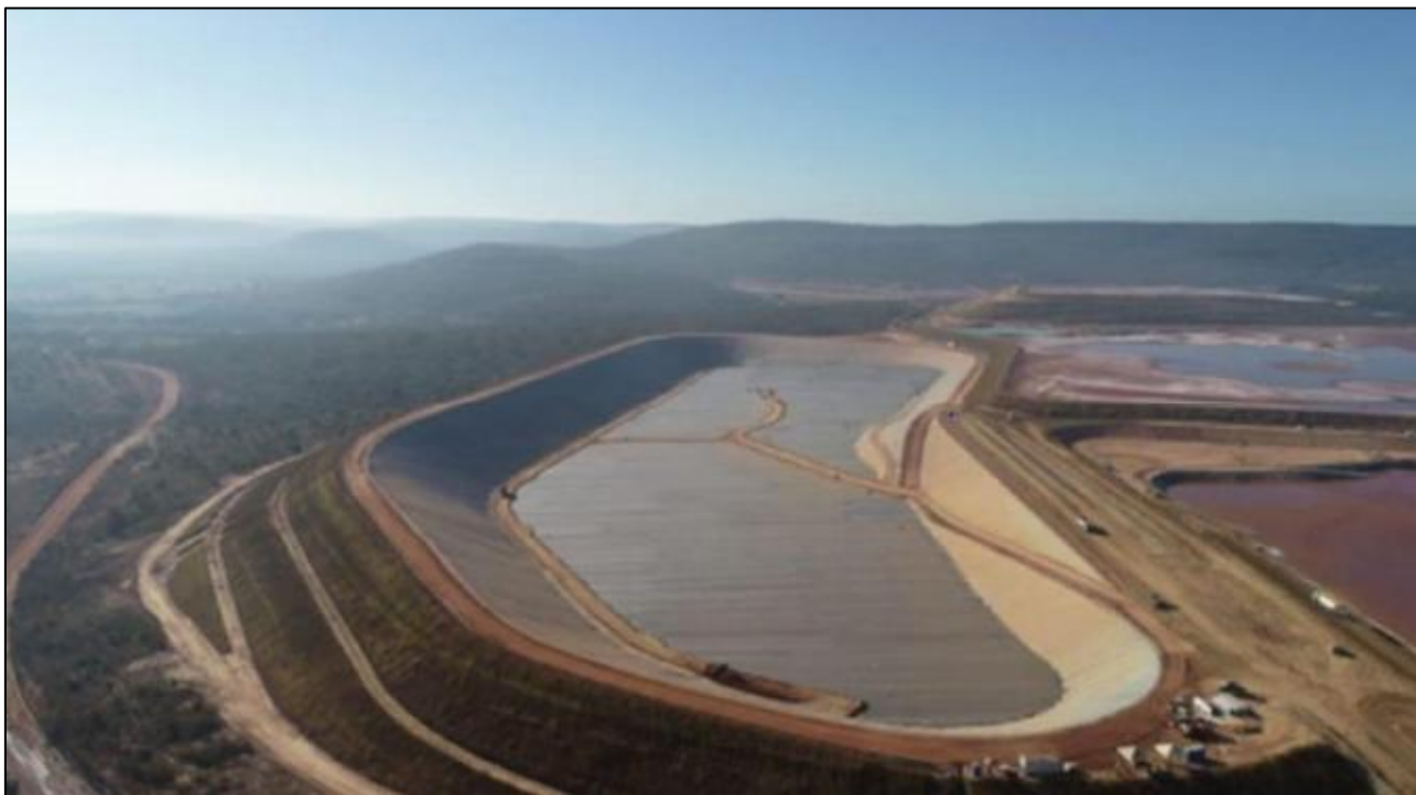
Figura 4.3 – Vista geral do Módulo Oeste 2 (Fonte: RL-I720507002-0603CIV7016_R0 ).
