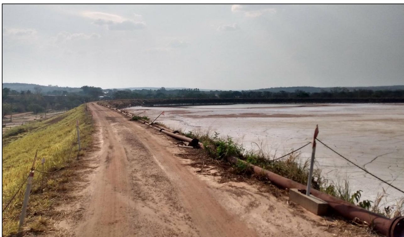
Figura 4.2 – Vista da crista do Dique de segurança.
