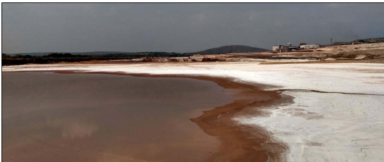
Figura 4.3 – Foto do reservatório do Dique de Segurança.
