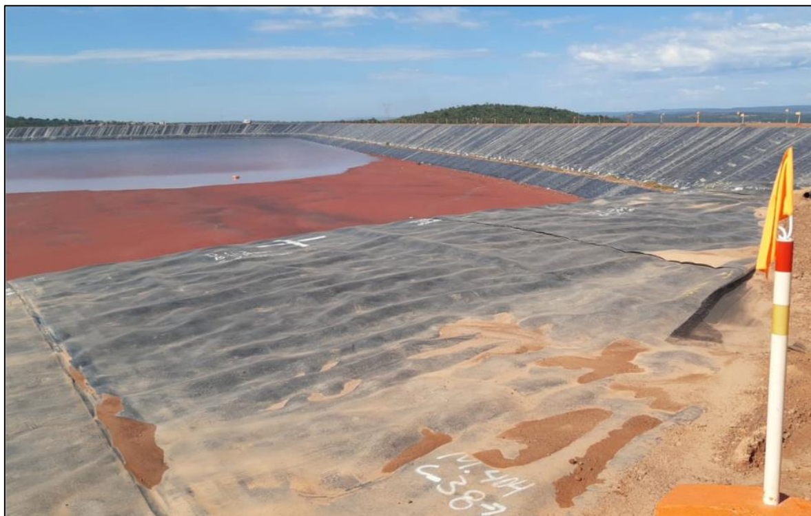
Figura 4.4 – Foto do reservatório do Módulo Oeste 1.
