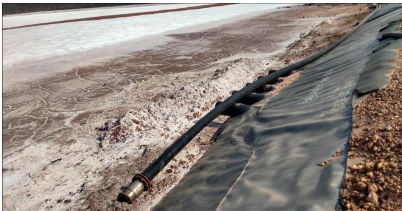
Figura 4.3 – Foto da estrutura extravasora do Módulo Central.
