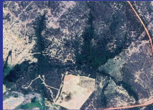
| Vista aérea do córrego Martinha
