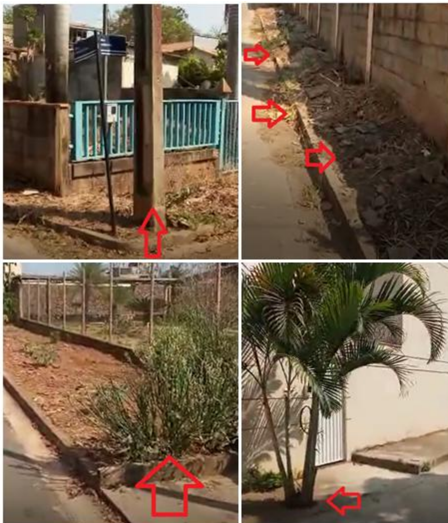
Figura 15-1 - Obstáculos presentes nas calçadas que inviabilizam a utilização dessas para a evacuação da população.
