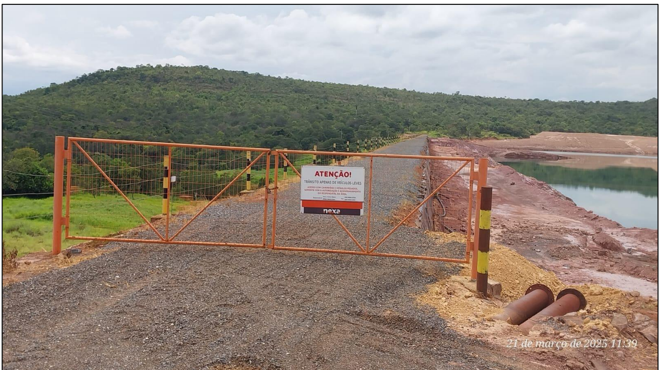
Figura 5.1- Controle de Acesso a Barragem Córrego da Lavagem.
