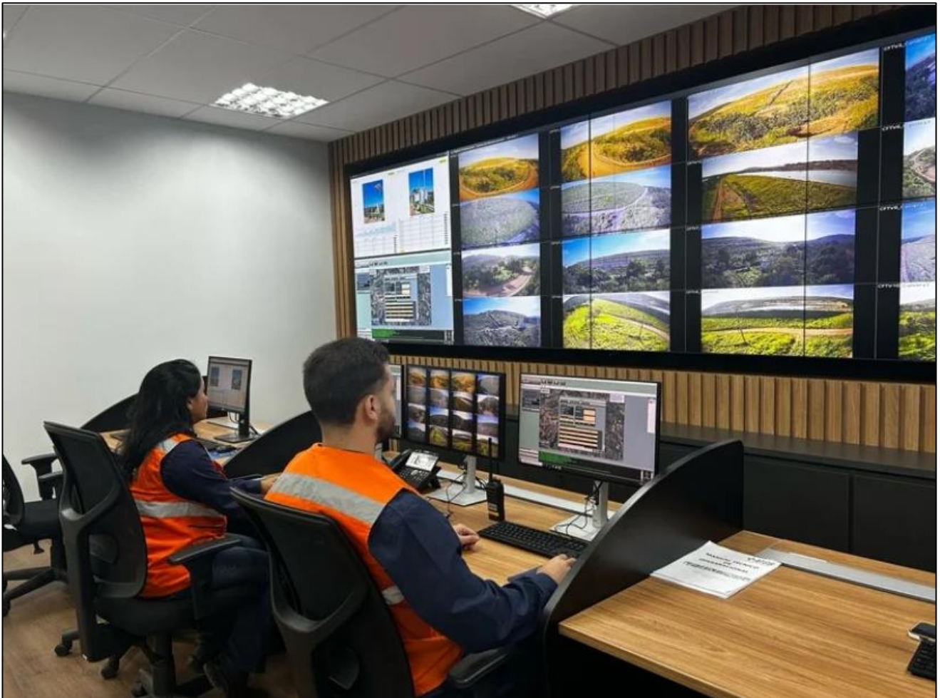
Figura 6.1- Centro de Monitoramento Geotécnico (CMG)
