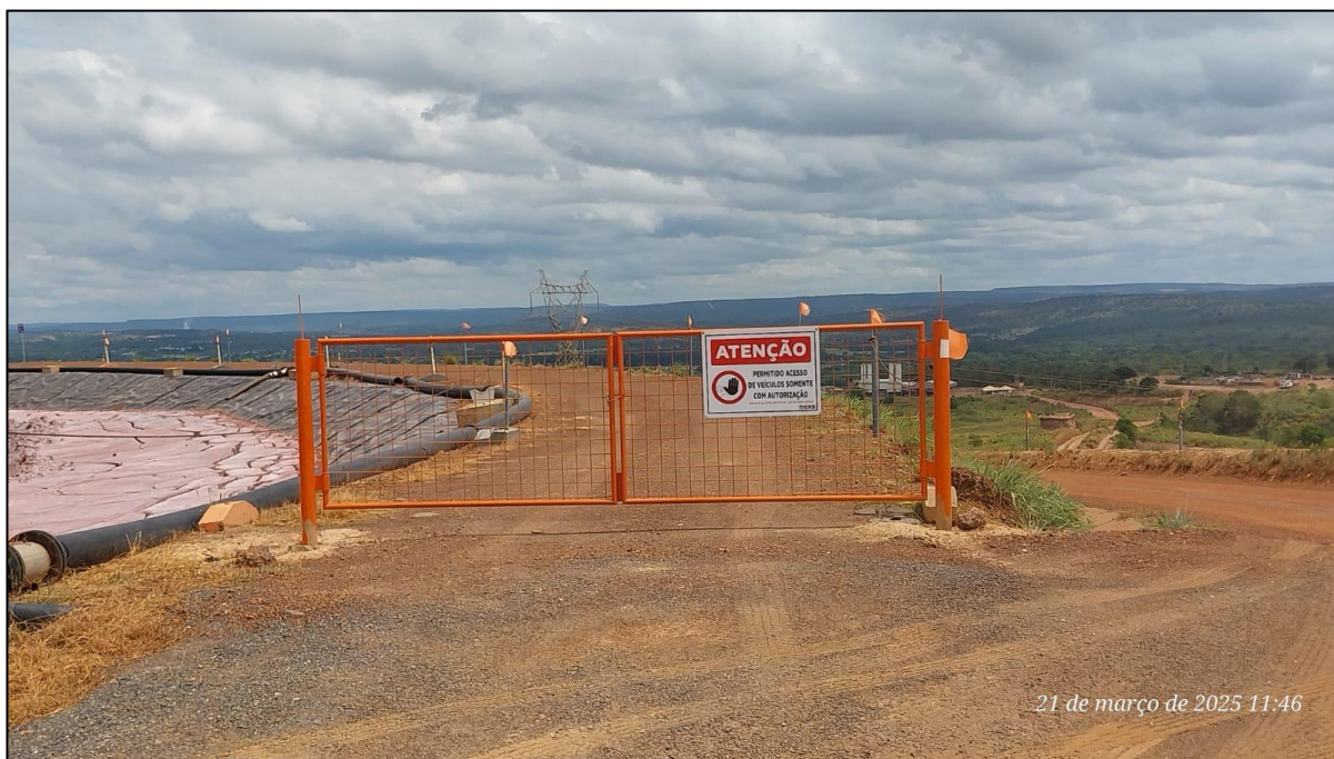
Figura 5.2- Controle de Acesso 02 Módulo Oeste 1
