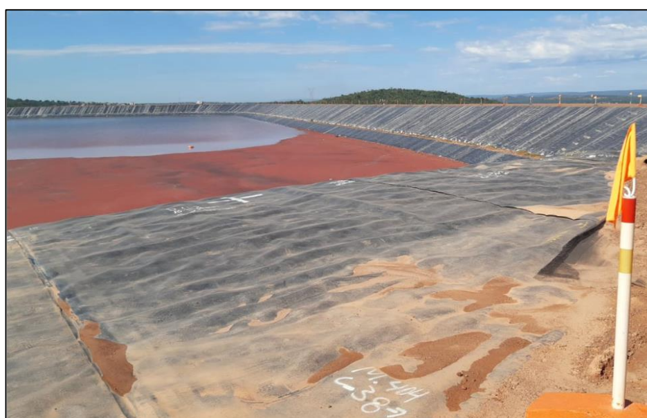
Figura 2.1 – Reservatório do Módulo Oeste 1
