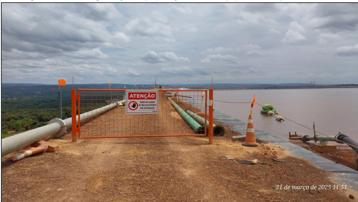
Figura 5.1- Controle de Acesso 01 Módulo Oeste 1
